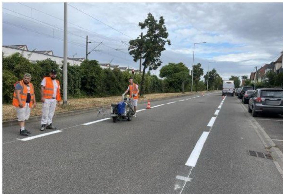
Le nouveau balisage de la rue des Papeteries consiste en une voie centrale banalisée, en phase de test. S'il est concluant le dispositif sera pérennisé. Photo Aurélien Gasser
