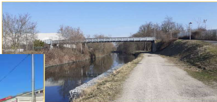
B : Passerelle du stadium (photo Artélia)
