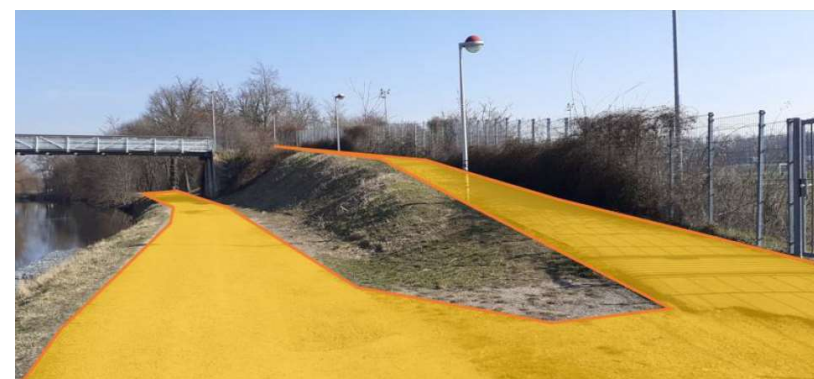
Rampe d'accès passerelle stadium
